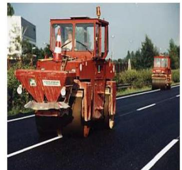
**Achtung!** Die Dauermarkierungsfolie darf mit der Walze nur unter Deckentemperatur von 40°C und nur einmal überrollt werden, da ansonsten das Waffelmuster zusammengedrückt wird und dadurch die verkehrstechnischen Eigenschaften beeinträchtigt werden.
